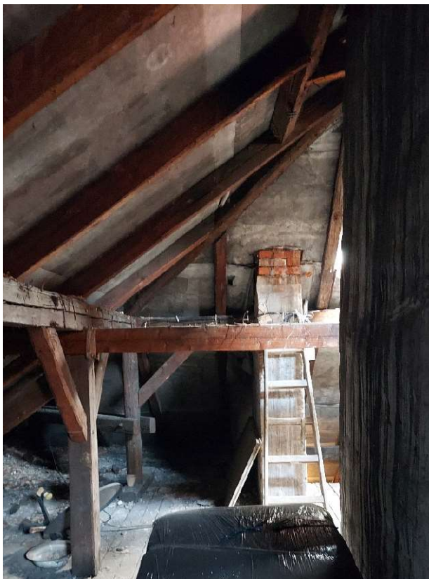
Fot. 1 Widok na konstrukcję więźby dachowej (krokwie, płatwie, słupy, kleszcze, miecze)
