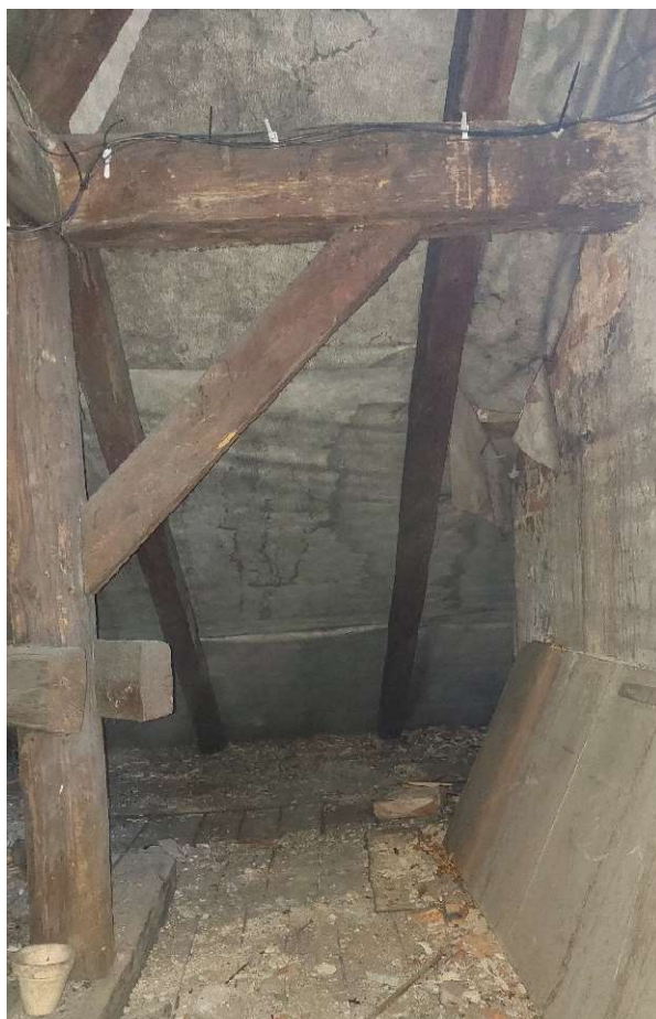
Fot. 2 Widok na zamkniętą membranę dachową i oparcie płatwii na kominie
