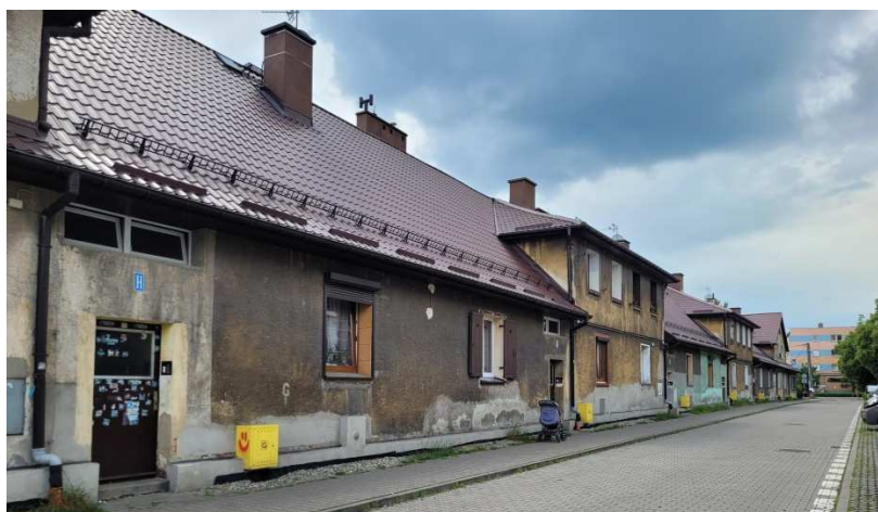
Fot. 1. Elewacja frontowa
