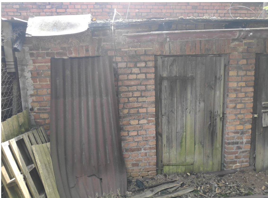
Budynek gospodarczy - widok od strony północnej.
