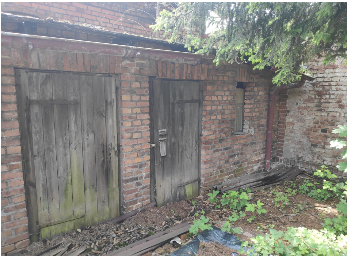
Budynek gospodarczy – widok od strony północno-wschodniej.
