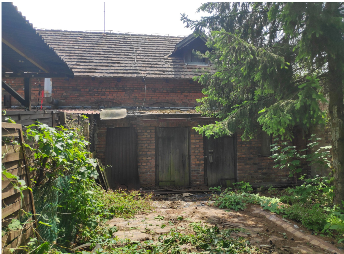
Budynek gospodarczy - widok od strony północnej.
