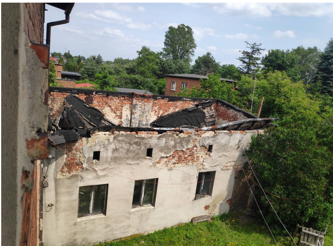
Budynek gospodarczy - widok od strony południowo-zachodniej.
