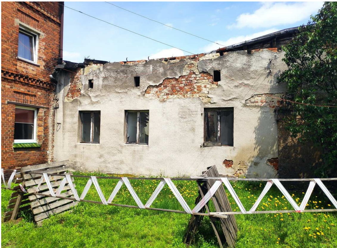
Budynek gospodarczy - widok od strony południowej.
