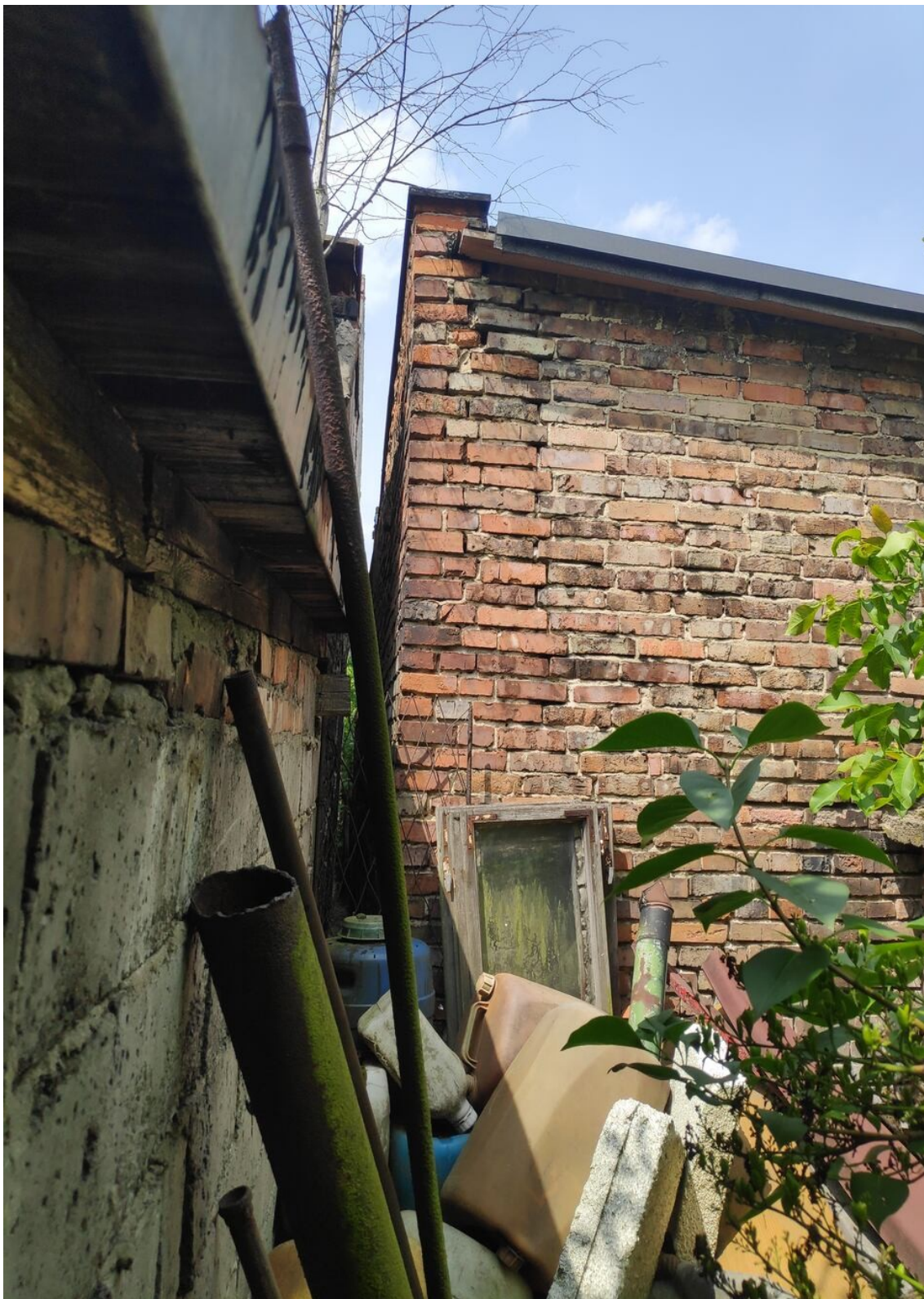
Widok od strony południowo wschodniej – szczelina pomiędzy budynkami przeznaczonymi do rozbiórki a budynkiem na sąsiedniej działce.
