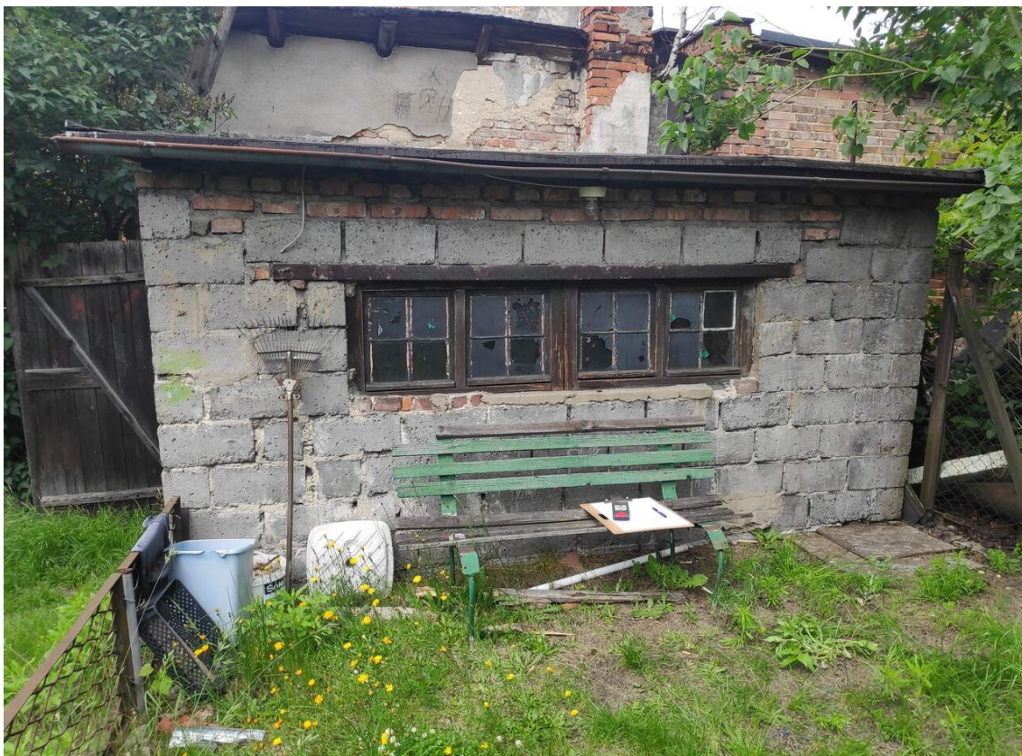
Budynek garażowy – widok od strony południowo-wschodniej.
