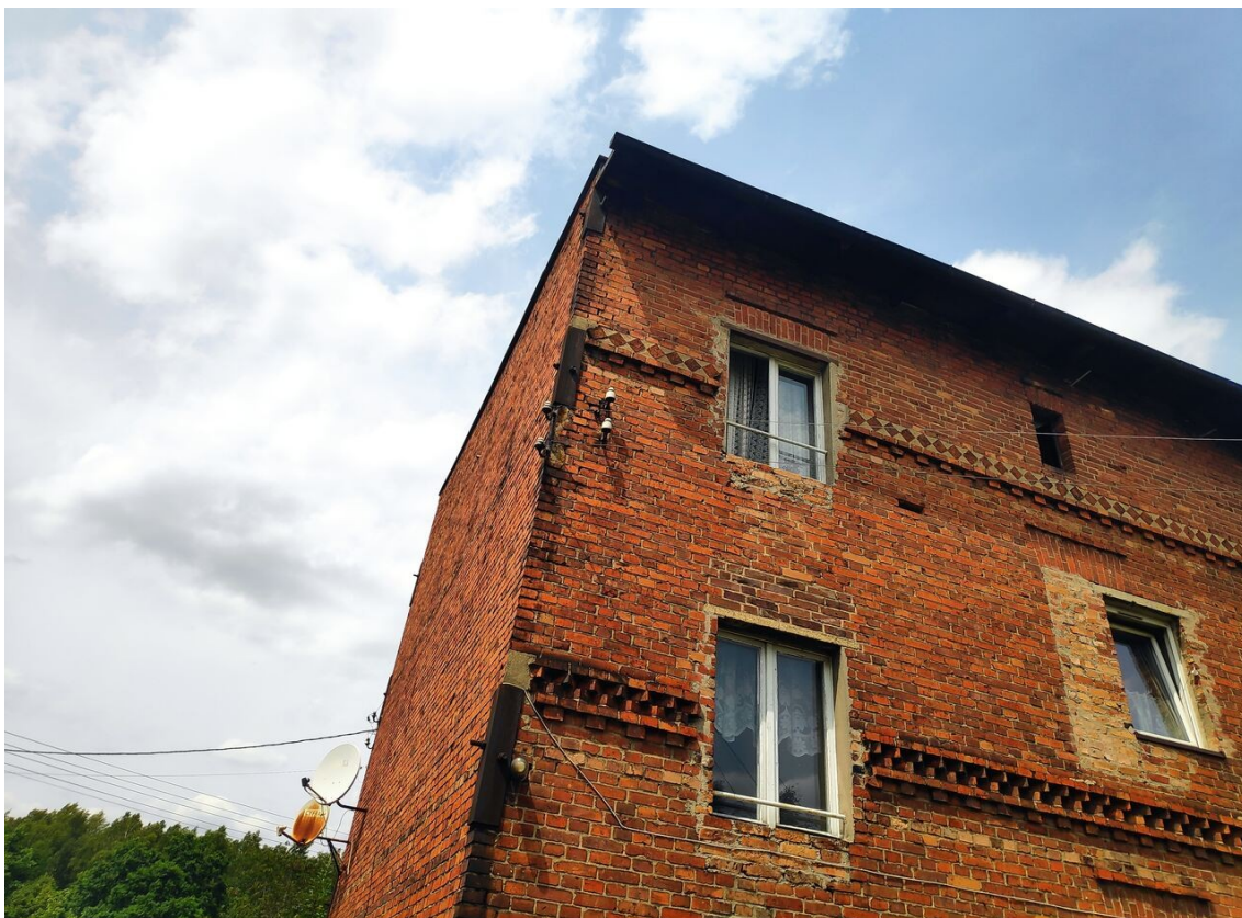
Narożnik budynku mieszkalnego, nieprzeznaczonego do rozbiórki, z konsolą po odłączonej linii elektroenergetycznej pomiędzy budynkiem mieszkalnym a budynkiem gospodarczym.
